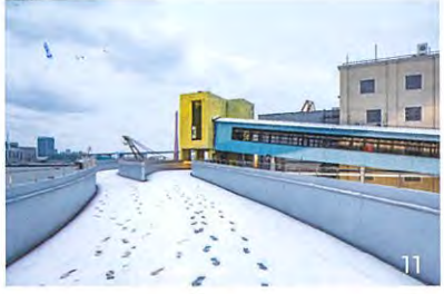
5~10. 同一区位改造前后对比 11、12. 雪后的贯通桥与中央广场 13. 中段休憩空间 14. 贯通桥下景观
