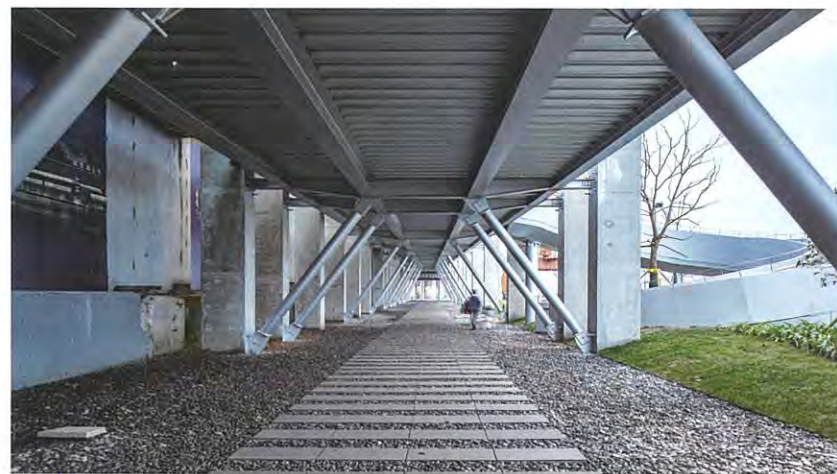
◎上海民生码头水岸改造及贯通 / 刘宇扬建筑事务所 / 田方方 贯通桥下的景观
