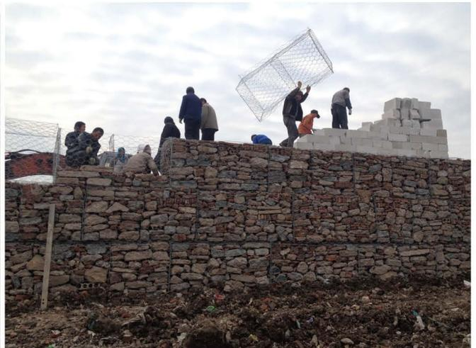
工人们将空石笼堆放在挡土墙顶层
