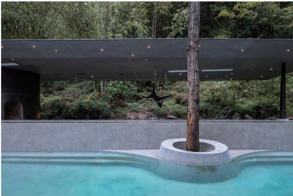
结构处理方式：采用淋浴区界面作为结构支撑（方案三）或采用更衣储物区界面作为结构支撑（方案四）。单从结构受力角度而言，采用外部储物区的界面作为结构时，屋面抗倾覆能力更优。
