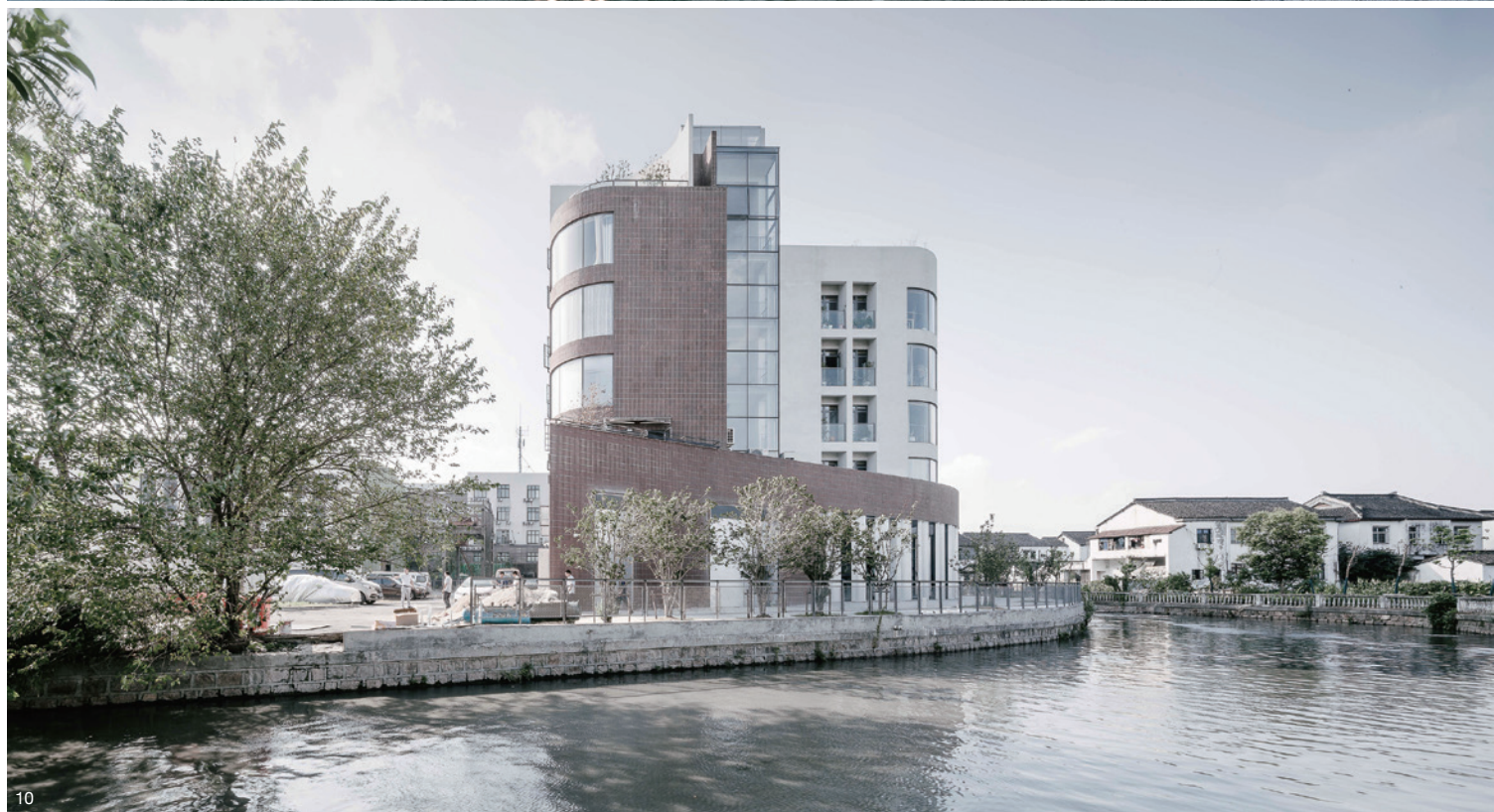
9 二期东立面 10 二期北侧沿河外景
