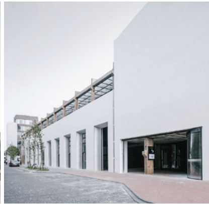
5 西区南面的屋顶露台
